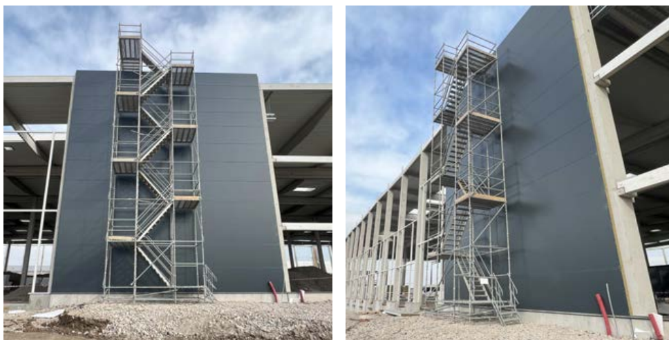
Kajima Czech Design and Construction s.r.o. - schodišťová věž, Praha
