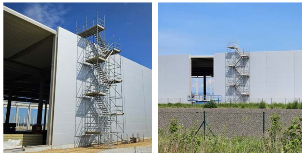
MARPRO STAV s.r.o. - schodišťová věž Cuplok, Mošnov
