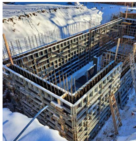
Stavby Kupšík, s.r.o. - bednění RD, Ondřejov
