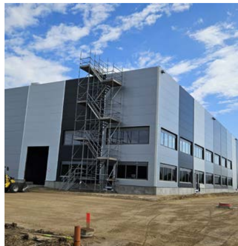
P-SYSTEMS STŘECHY s.r.o. - VGP Hala E, Hněvotín
