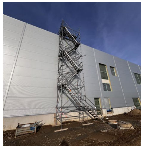
Izolex Moravia, spol. s r.o. - Hala SMC, Vyškov
