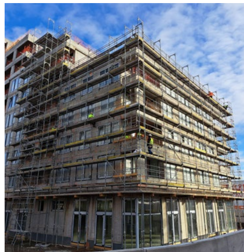
VCES a.s. - Hloubětín, objekt A, D
